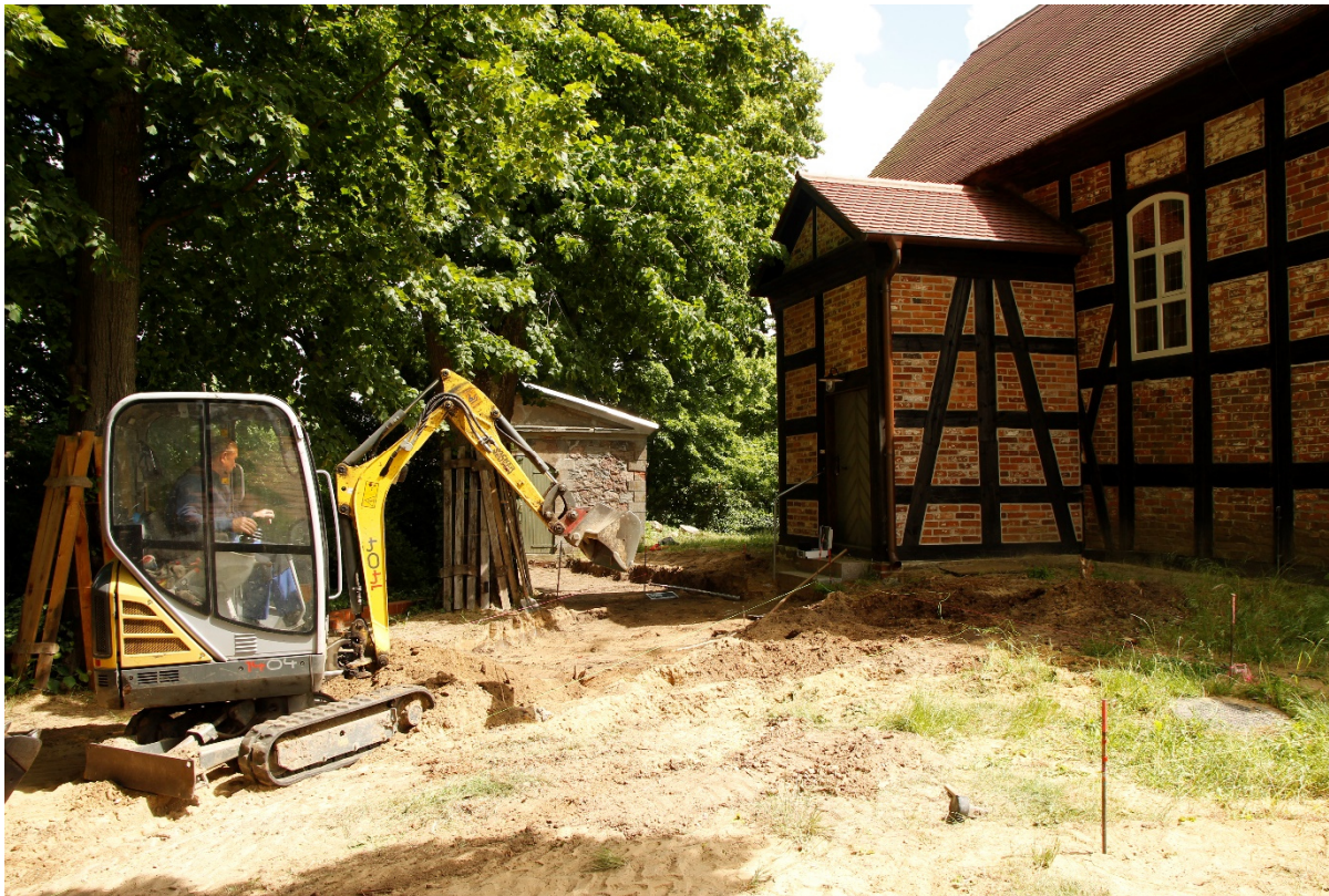
Abb. 1: Erdarbeiten für die Zuwegung zur Dorfkirche Landin
